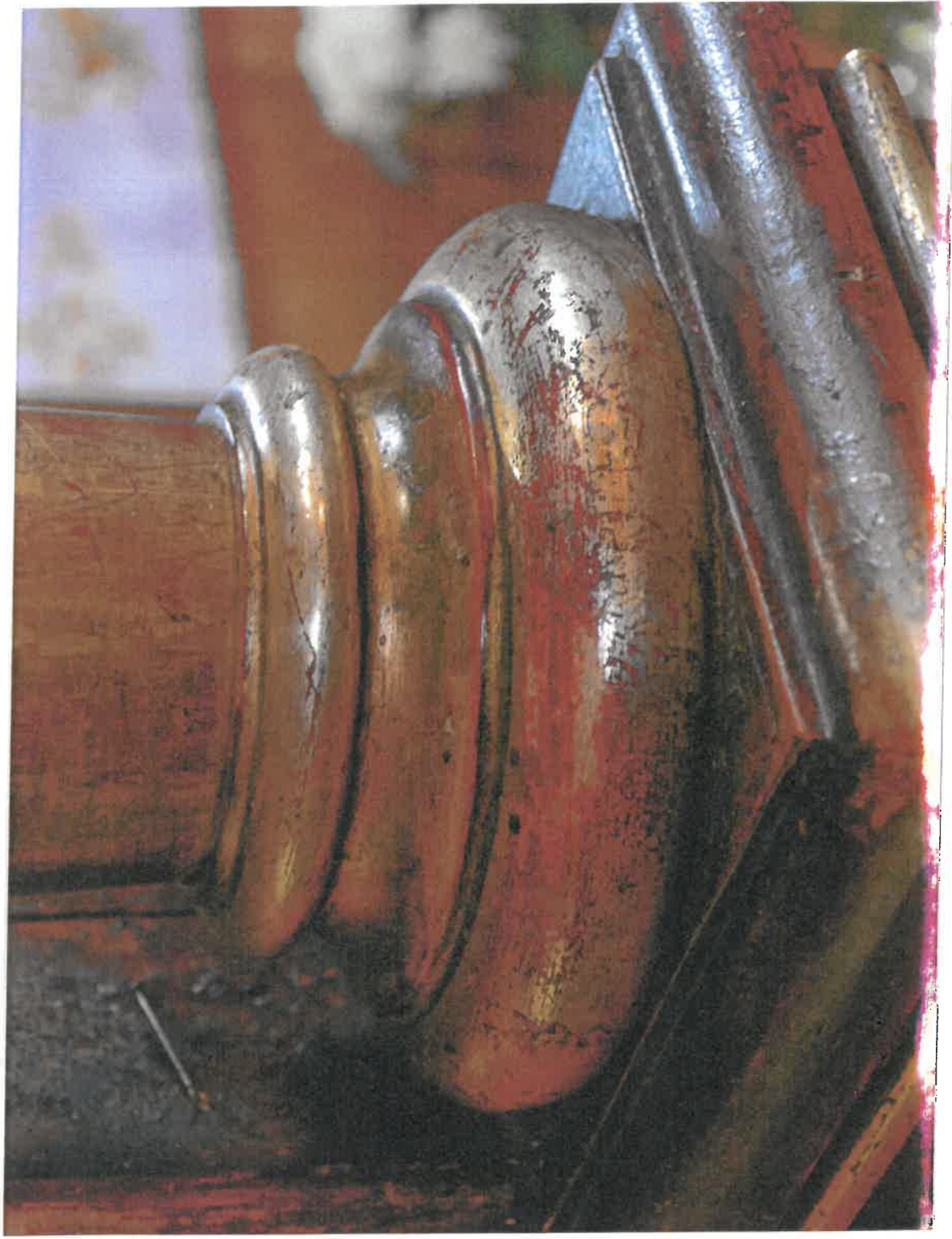
Ikonostas w Rabem/ Detal , złożona baza kolumny. Widoczne przemycia złoceń do pulmentów. 2024 r.
